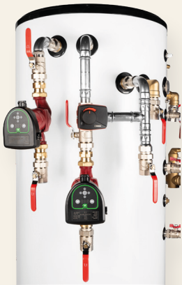
KEVERTKÖRI EGYSÉG HWT - 500 ESBE VRG132 DN32
